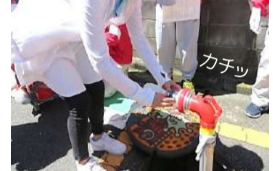
消火ホース接続
