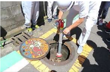
消火配管接続
